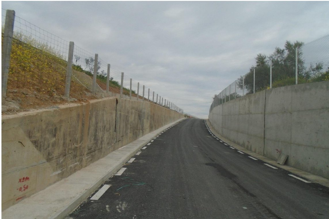
SR003L – Ολοκλήρωση εργασιών
