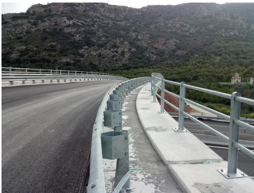
A223 – Αντικατάσταση στηθαίων ασφαλείας
