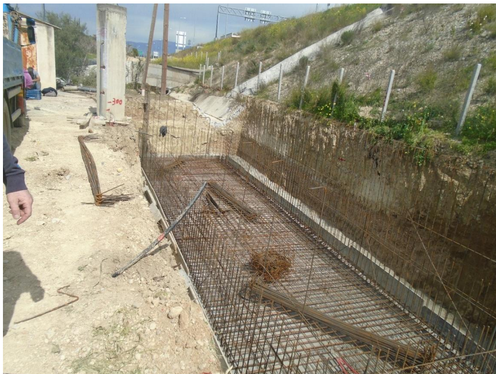
B131 – Κατασκευή δεξαμενής κατακράτησης
