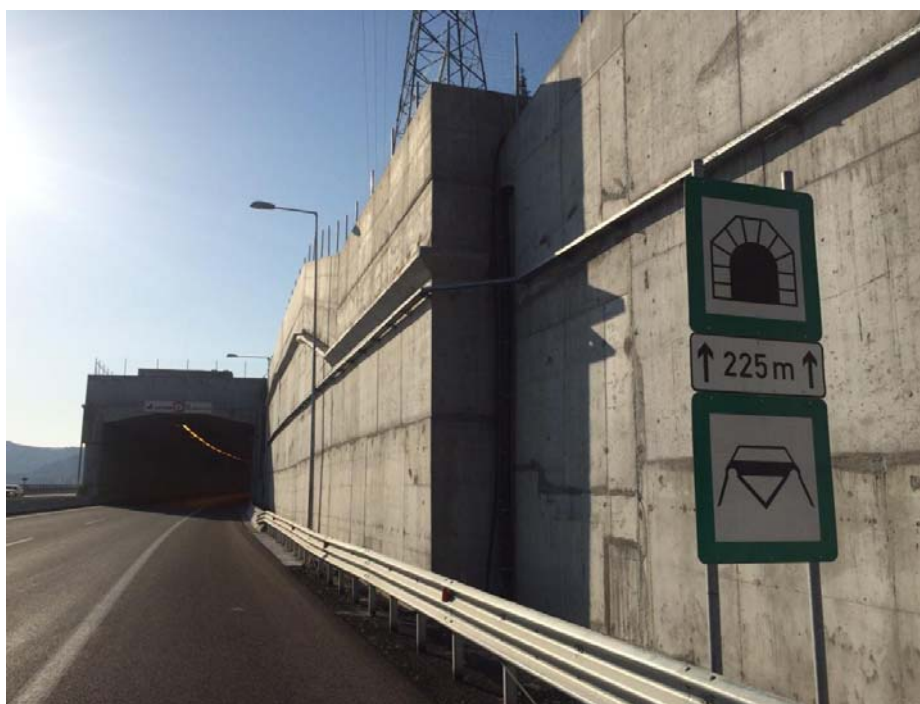
Εγκατάσταση περίφραξης στις πλευρικές οδούς
