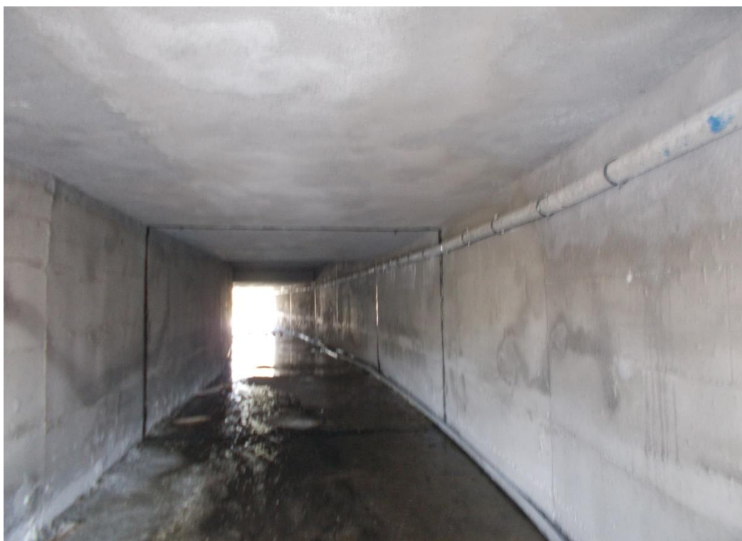
Εργασίες αποκατάστασης στο τεχνικό S050
